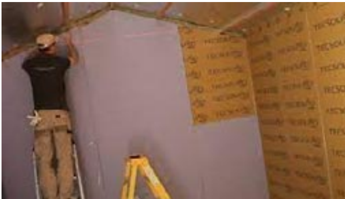
Tecsound 70 SY avtak dekkplast- , videre Tecsound på gulv, SY på vegg og SY i tak.
