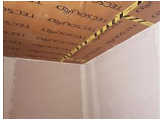
Tecsound 70 SY avtak dekkplast- , videre Tecsound på gulv, SY på vegg og SY i tak.
